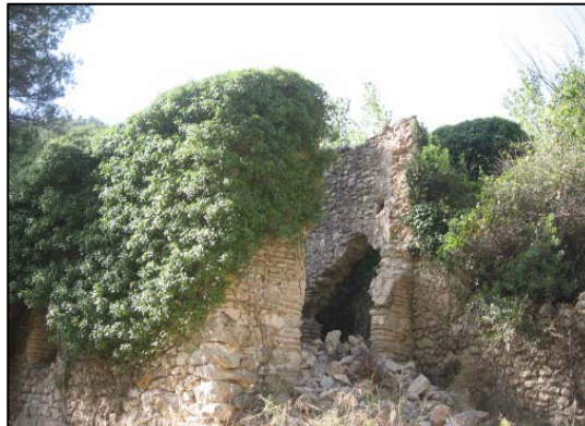
Foto 5: Ruinas de un antiguo horno
